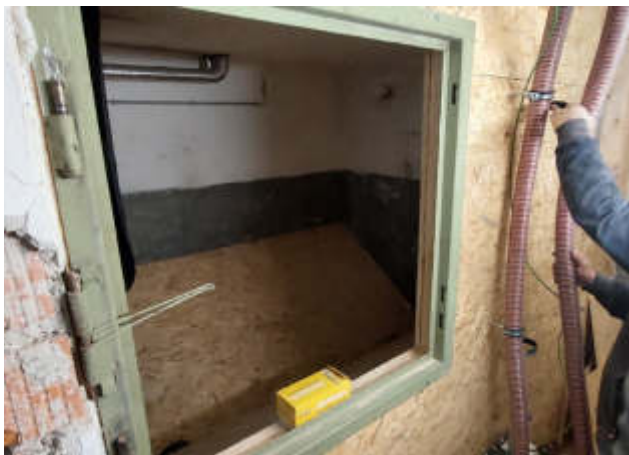
Öltank raus - Pelletslager rein (6m³)
