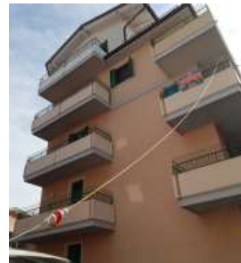
Laden beim Appartement in Italien mit 20m Verlängerung
